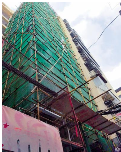
图 3 施工期间现场作业
