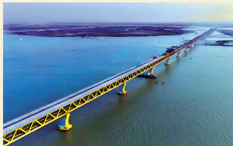
孟加拉帕德玛大桥—中铁大桥局
