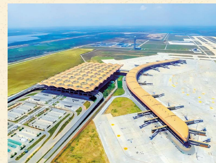
柬埔寨德崇国际机场—中建三局
