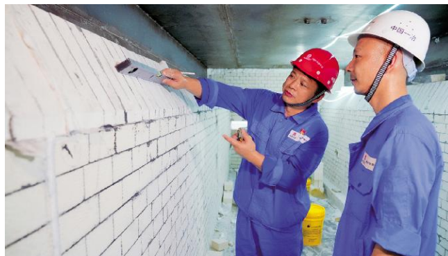
吴春桥在武钢炉窑施工现场与同事共同检测实体砌筑精度
