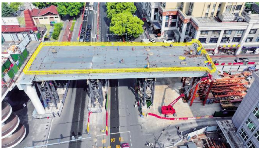
钢箱梁分段完成后临边防护
