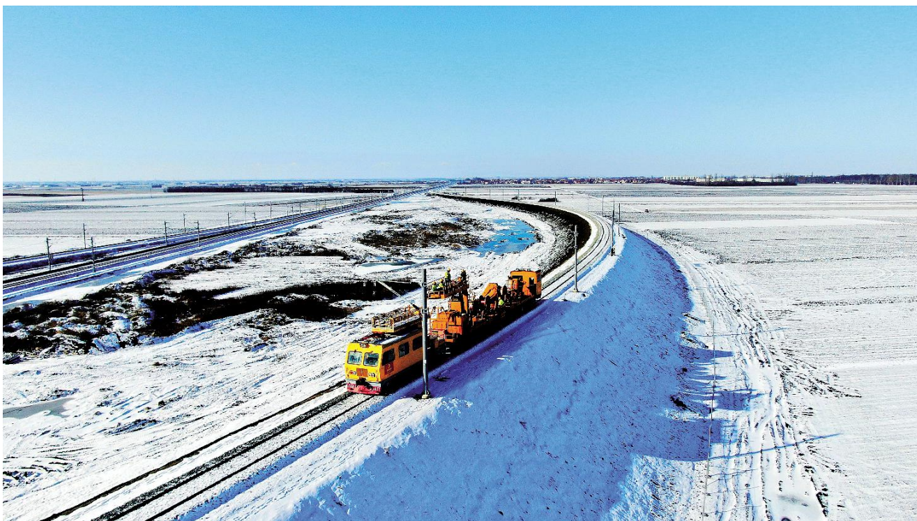
2022 年 1 月 23 日,中铁建电气化局恒张力放线车,在匈塞铁路放线作业。(中国铁建电气化局供图)
