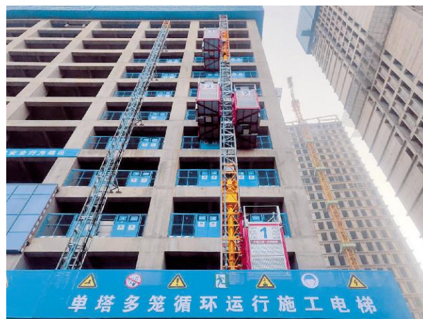
图 2:单塔多笼循环运行施工电梯
