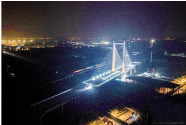
2025年3月27日凌晨3时,随着最后一度精准对位,中铁大桥局承建京港澳高速公路湖北省北段改扩建工程控制性节点——上跨汉丹、汉宜铁路立交转体斜拉桥历时45分钟顺利完成77.3°转体作业。这座转体重量达33000吨、转体总长度达186.8米的独塔斜拉桥,以0.032弧度/分钟的精准速度平稳跨越7条繁忙铁路线,刷新全球齿轮齿轨式转体桥梁的
