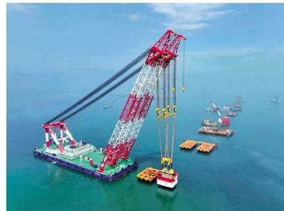
首个预制墩台的高精度吊装，验证了该项目智能建造装备的适用性，展示了项目团队技术实力，为后续海上大规模预制墩台连续安装作业提供了标准化技术示范。
