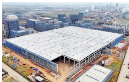
磷化工项目成品库
