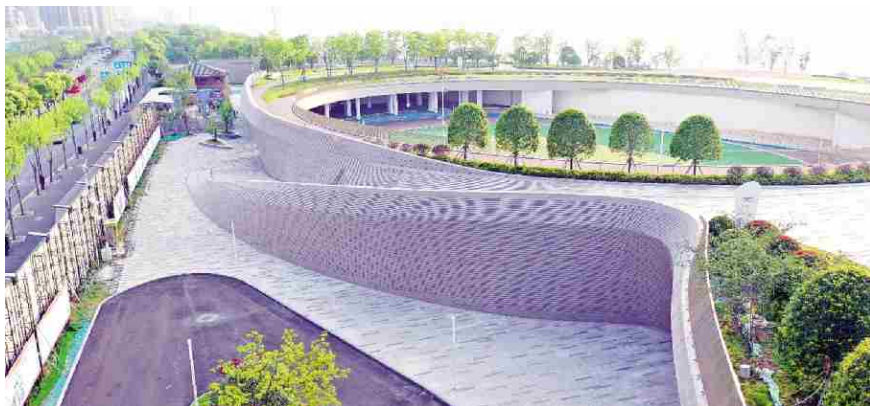
图10 月亮湾城市阳台项目 UHPC 幕墙现场实景图
