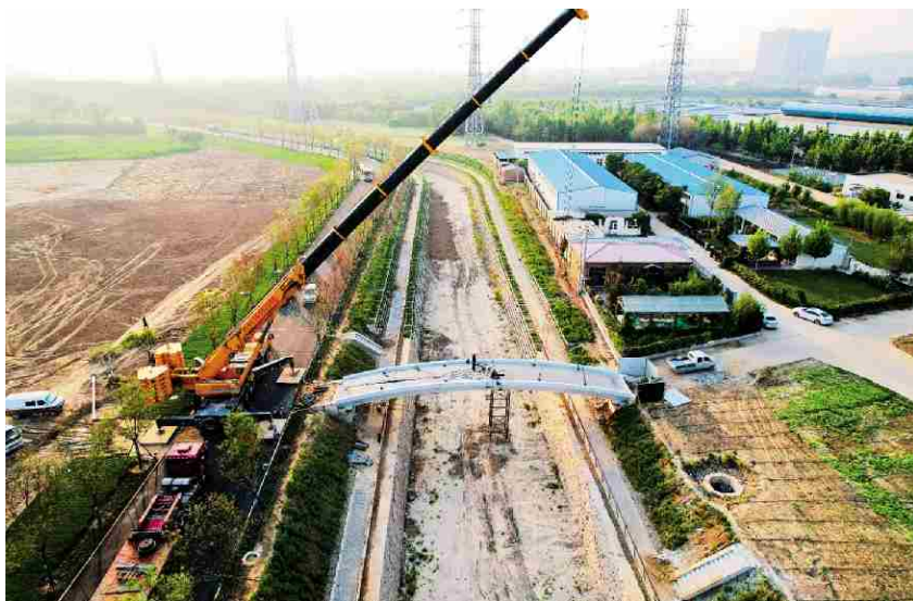
2022年9月17日，中铁十一局四公司保定大水系项目部在吊装人行钢桥。（张路路摄）
