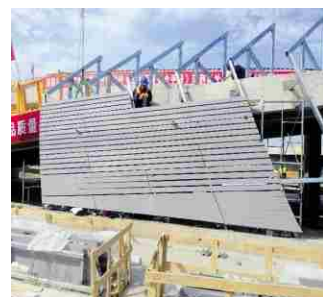
图9 UHPC幕墙板块安装调节图
