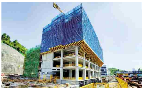
鄂西南重大疫情救治基地项目 外墙脚手架实景图
