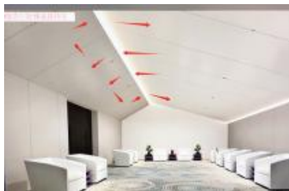
为精装美观度优化结构主次梁的高度
