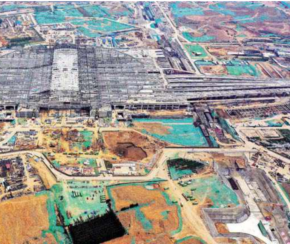
雄安站最新航拍
