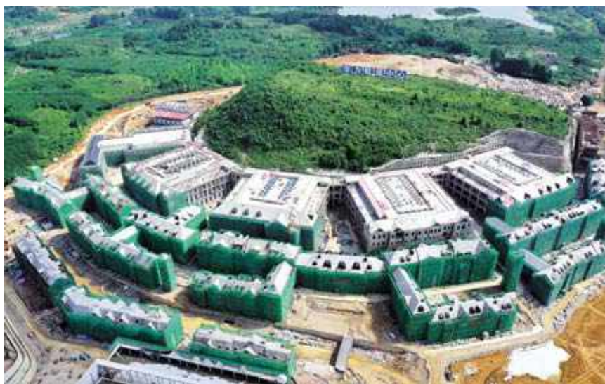
贵安华为云数据中心
