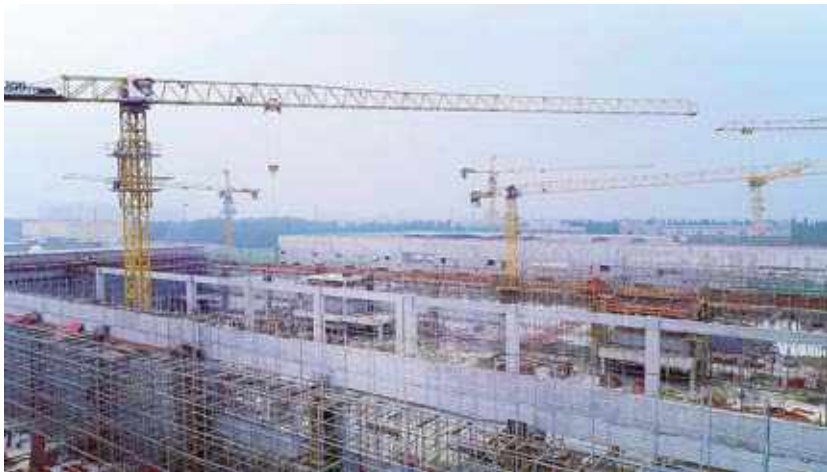
武汉顺丰项目智能化分拣中心建设实景
