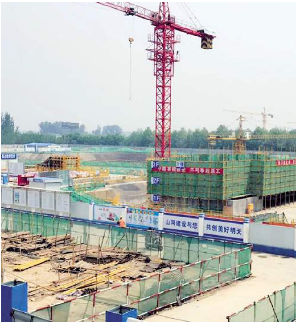
2017 年，河南公司承建的融创·融园项目现场
