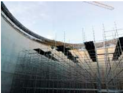
图 2: 盘扣架搭设示意图
