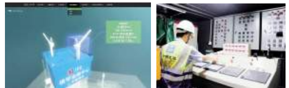
图 10 塔吊及顶模监控系统
