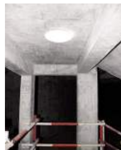
图6 临时用电与永久照明相结合
