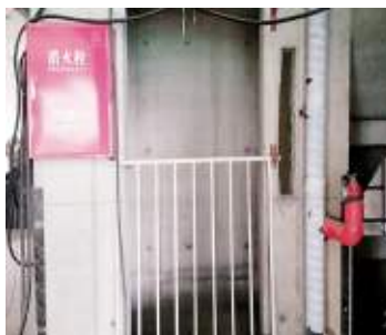
图5 正式消防管道做临时消防管
