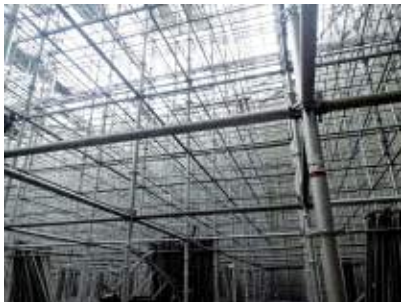
图 1: 盘扣架搭设示意图
