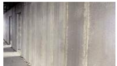
图 2 隔墙板现场施工照片
