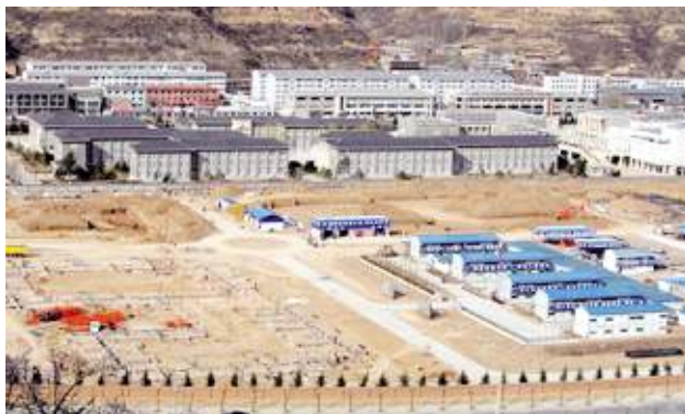
图4 永久道路与临时道路结合布置现场实况图
