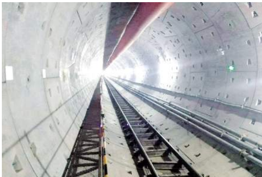
成都地铁5号线9标盾构成型隧道
