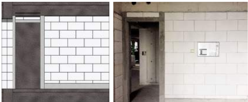
图6 墙体三维深化设计图与现场施工图对比
