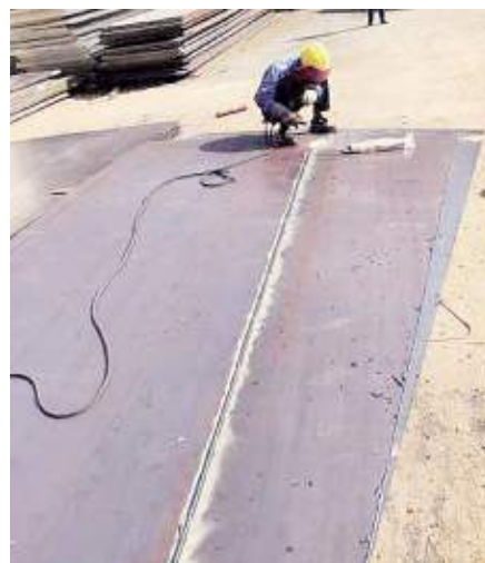
图8:钢板焊接图
