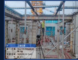
05 水平预制构件吊装
